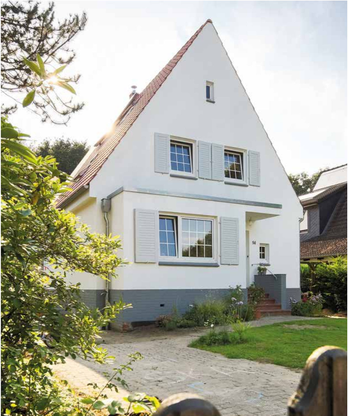
Abb. 3: Straßenansicht des sanierten Siedlungshauses aus den 30er-Jahren
