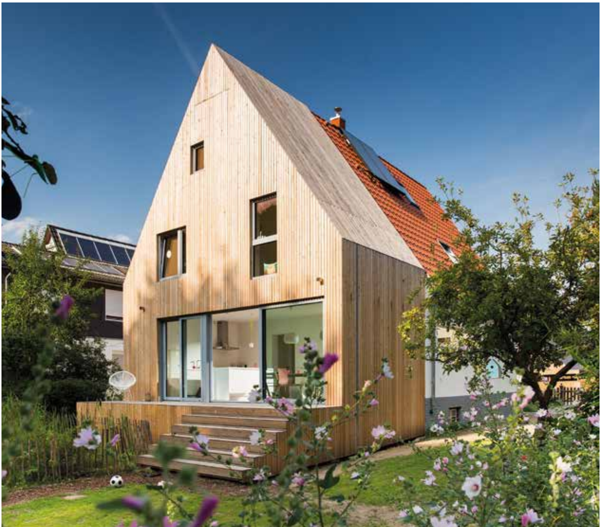
Abb. 1: Monolithischer Anbau in Holzbauweise mit großen Fensteröffnungen und Terrassenpodest in den Garten
