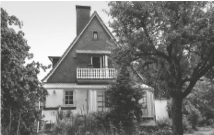
Abb. 2: Wohnhaus vor der Sanierung
