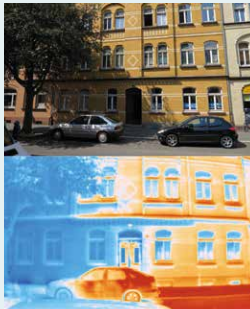
Abb.10: Foto und Thermografie-Aufnahme eines Wohngebäudes im städtischen Straßenraum. Die Thermografie verdeutlicht, dass der Schatten des Baumes die Fassade nachhaltig kühlt.
